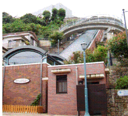
写真5 斜行エレベータ
