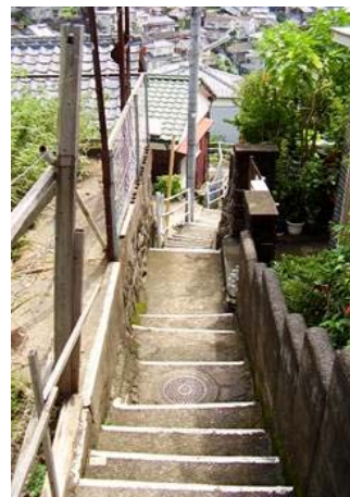
写真2 狭く不規則な階段通路
