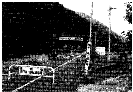
写真5 久木野側入口
