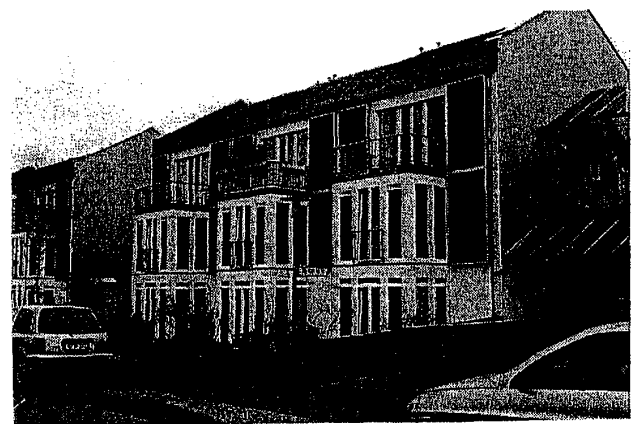
写真 5 ベルリン市 Heerstrasse の環境共生住宅
