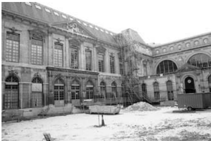
【図2】 改修工事中のフランス国立図書館旧館
