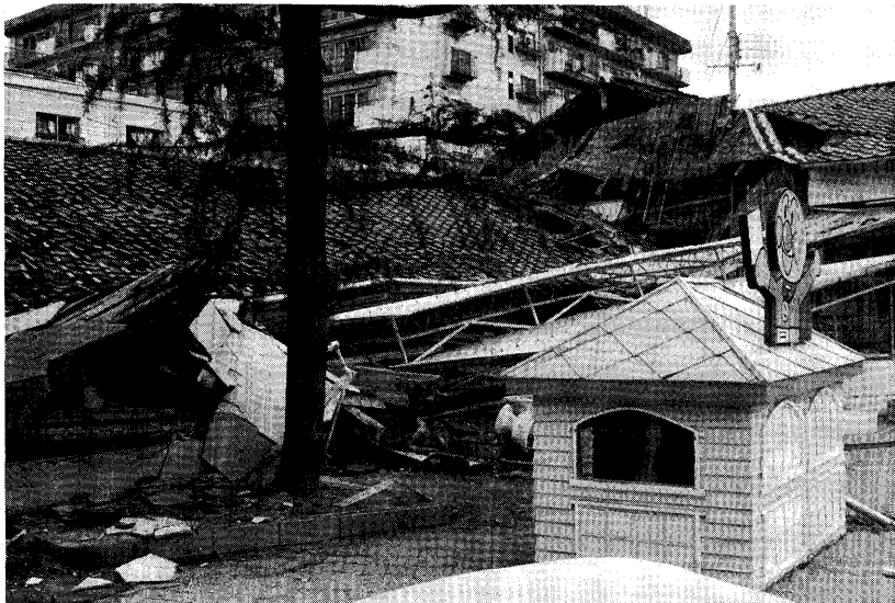
▲倒壊した木造園舎
