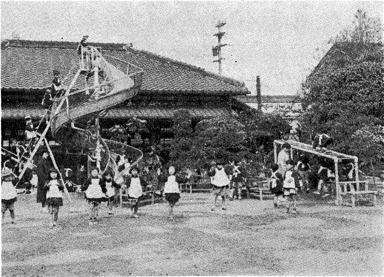
廻すべり台の金網の修繕
