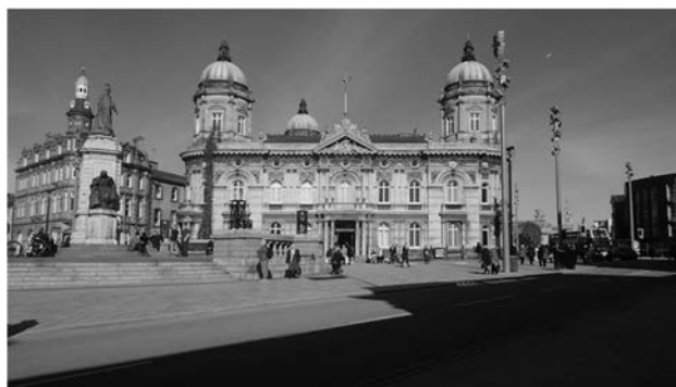
写真：ハル市内のミュージアム
