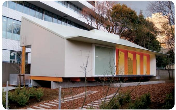
ム構法」を開発し、シンプルで一体的な空間を実現しています。間伐材を利用した「パネルフレーム構法」は、森林保全や、建物の長寿命化においても有効な新しい構法です。
