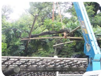
クレーンでつり上げられている藤棚
