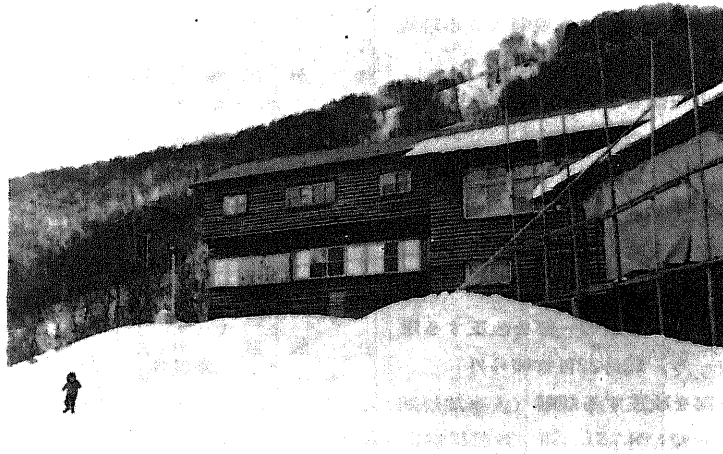
志賀高原体育運動場 と建築中の研修センター管理棟
