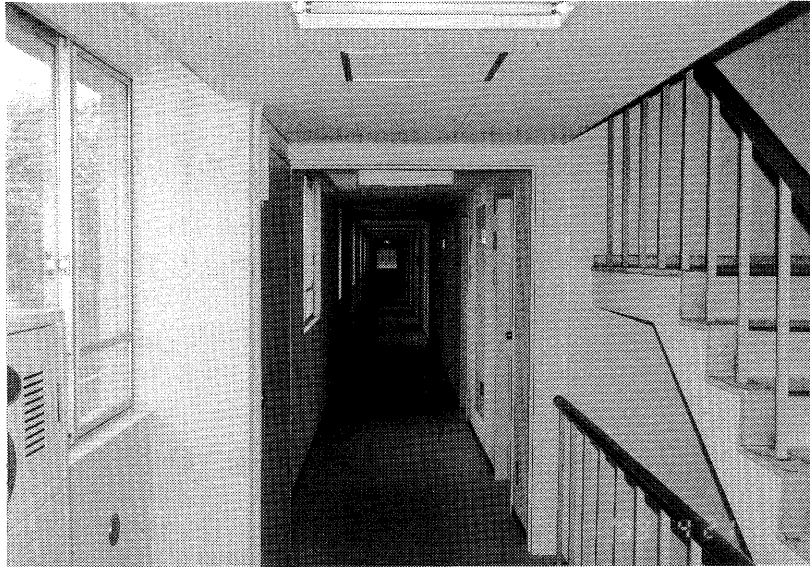
A棟1階廊下
