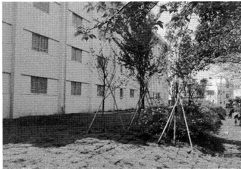
A棟外観及び北側植栽
