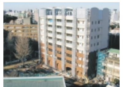
完成間近の総合研究棟 1号館
