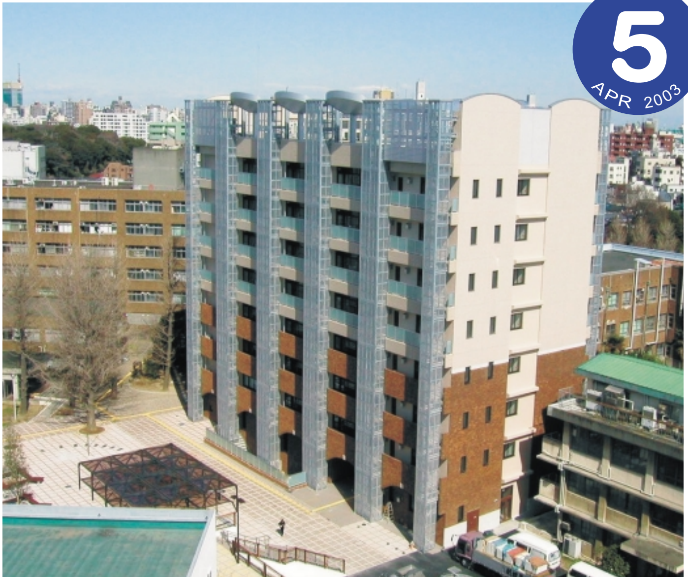
総合研究棟1号館
