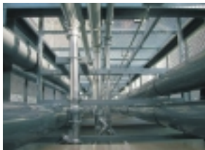
外壁のシャフトの内部
