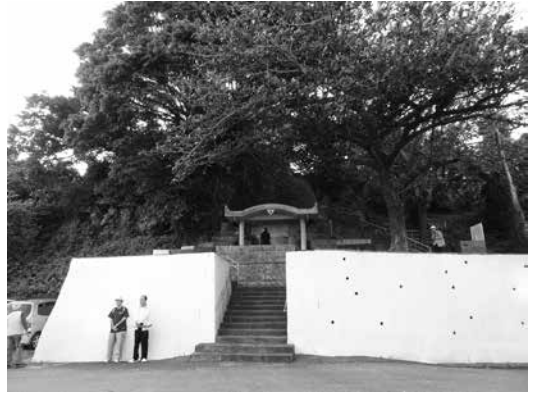
写真5 ユーチー墓外観
