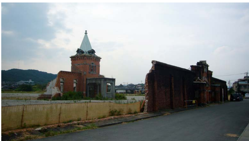
写真6 正門及び管理棟の一部が残る現在の旧長崎刑務所
