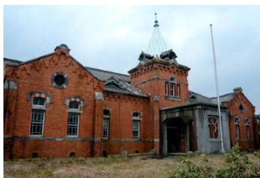
写真5 解体前の庁舎正面
