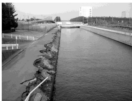
写真5 東日本大震災で護岸が崩壊した菊田川 (写真提供:千葉県立中央博物館 高橋直樹氏)
