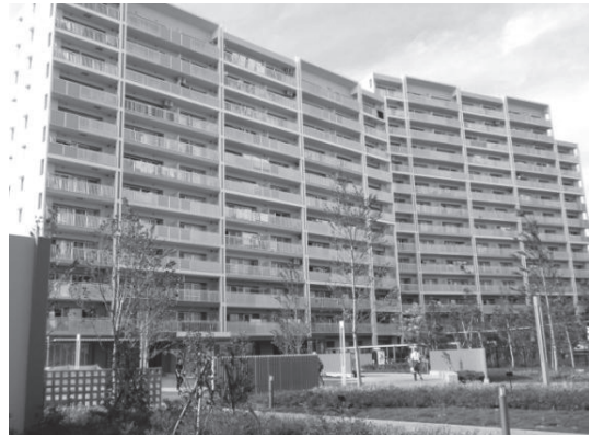
b. 建替え後住宅（先工区）
