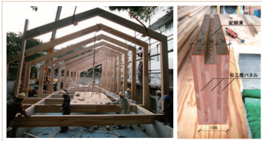
図-7 建設中の実験住宅(左)とフレームに用意された配線溝(右)
