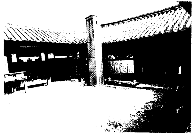
<写真1>朝鮮時代の上流住宅の煙突 *安東市河回村(北村宅)、著者撮影
