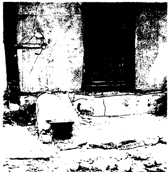
<写真3>オンドル房の前に設けられた暖房専用の焚き口 ここでは庶民住宅の「土榻」とはオンドルであり、庶民がそれをつくる理由を、貧窮の故なのであるという。12世紀初、徐競が訪れた高麗の都松都(現開城)は韓半島中部にあるとは言え、風土的には北方的である。
