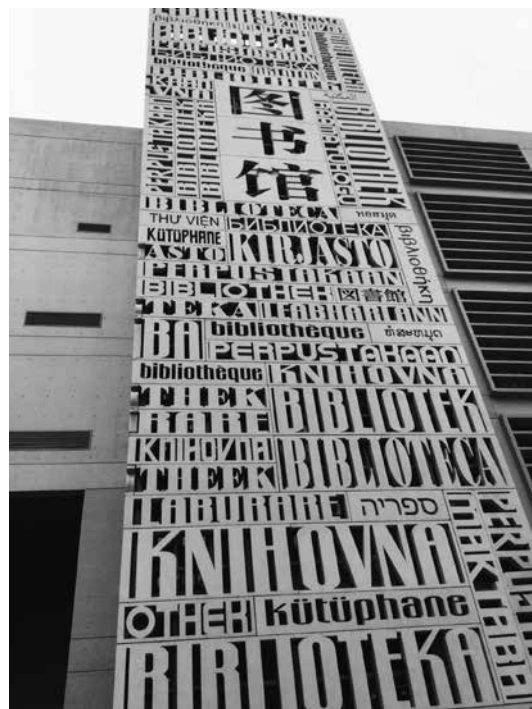
北京外国语大学图书馆 外壁
