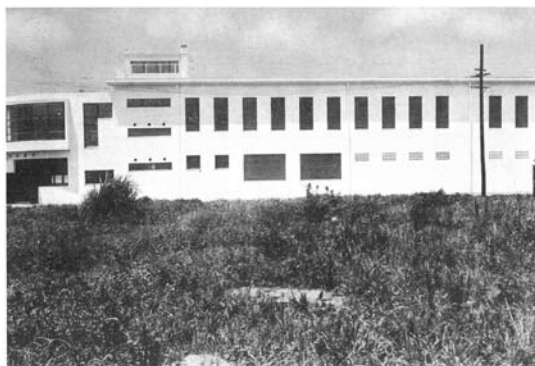
正面外観 front view
