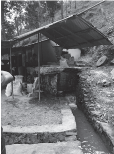
写真2 水力発電小屋の様子
