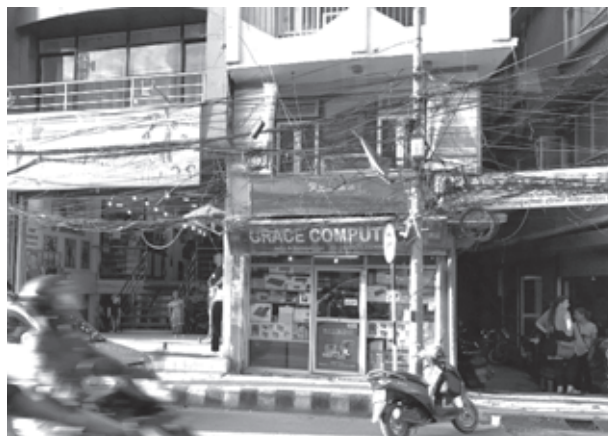
写真1 カトマンズ市内の電線の様子
