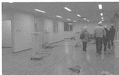
▲工事中的様子(2階保育室全体)
