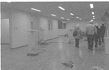
▲工事中的様子(2階保育室全体)
