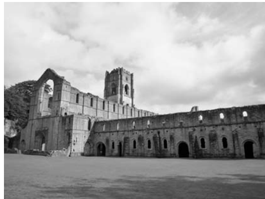
図3 最盛期に約150人を収容したといわれるファウンテンズ大修道院 著者撮影
