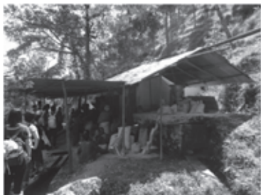
小型水力発電所の見学
