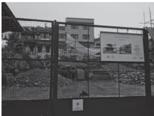
写真1 パタンのダルバールスクエアにて 倒壊した寺院と山積みされたレンガ
