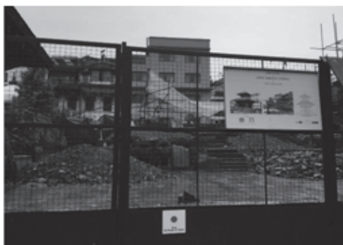
写真 2 ダルバール広場の壊れた仏塔
