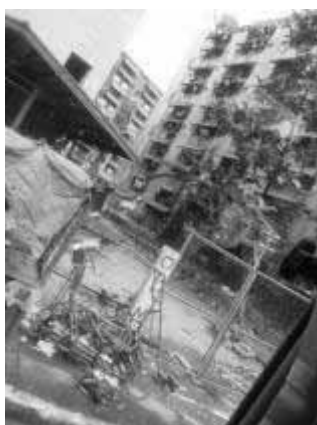
写真1 トンド地区・ごみ山近辺の公共住宅
