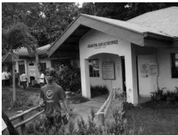
写真1 ニュールセナ役場に設置された手すり とスロープ
