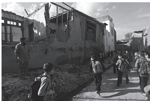
地震で被害を受けた建物
