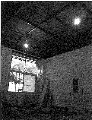
▲格天井が出てきたところ
