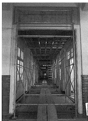
▲足場が組まれた廊下
