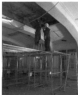
▲遊戯室天井に空調設置
