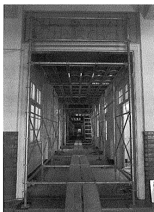
▲足場が組まれた廊下
