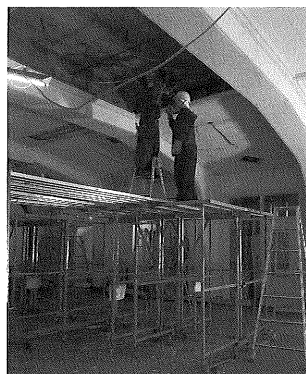
▲遊戯室天井に空調設置
